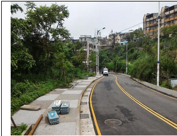
點 1：上邊坡為農作種植，邊坡與既有樓房高差約 10~15m；下邊坡植生狀況良好且道路鋪面良好
