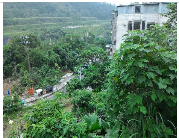
點 6：敏感區上邊坡現況穩定，坡面植生良好，無明顯邊坡滑動跡象
