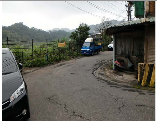
點 4：敏感區上邊坡坡頂現況穩定，無明顯邊坡滑動跡象
