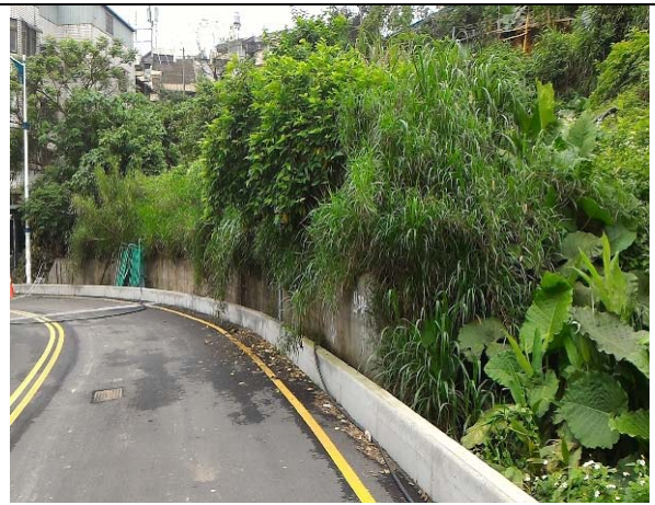
點 2：坡面表土覆蓋，既有擋土牆約 1m 高，無岩層露頭出露
