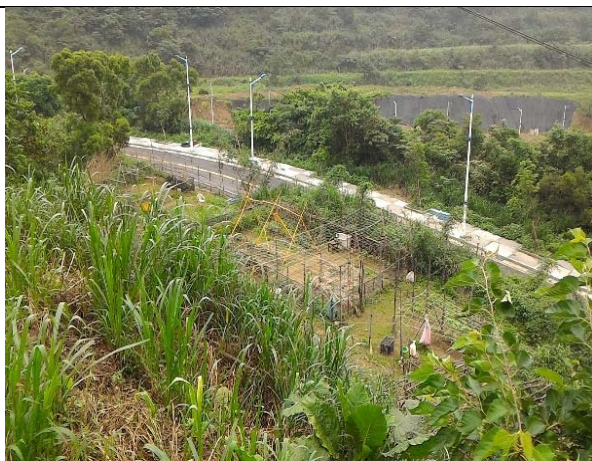
點 5：敏感區上邊坡坡面植生覆蓋完整，無明顯邊坡滑動跡象
