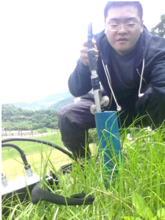
監測施作照片 2
