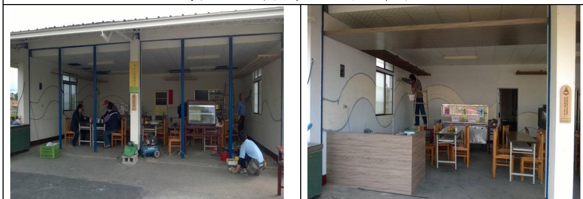
烏塗社區農產推廣中心裝修中
